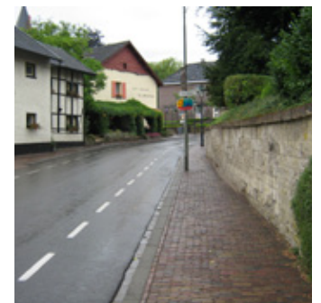
Muren vangen forse hoogteverschillen op.
